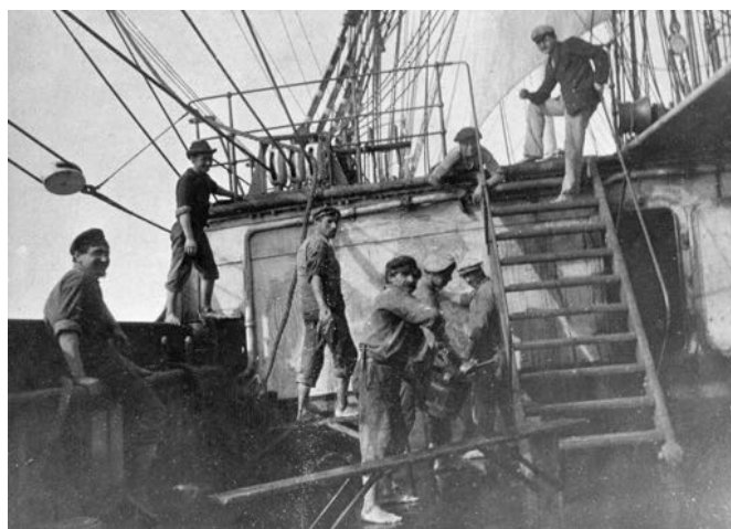
Piquer la rouille et passer du minium, c'est entretenir le navire ; laver les surfaces à la potasse et les peindre lui redonnent sa beauté.
