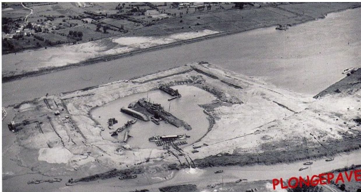
Autre vue aérienne du batardeau. On distingue la station de pompage et ses tuyaux dans le bas de l'image
