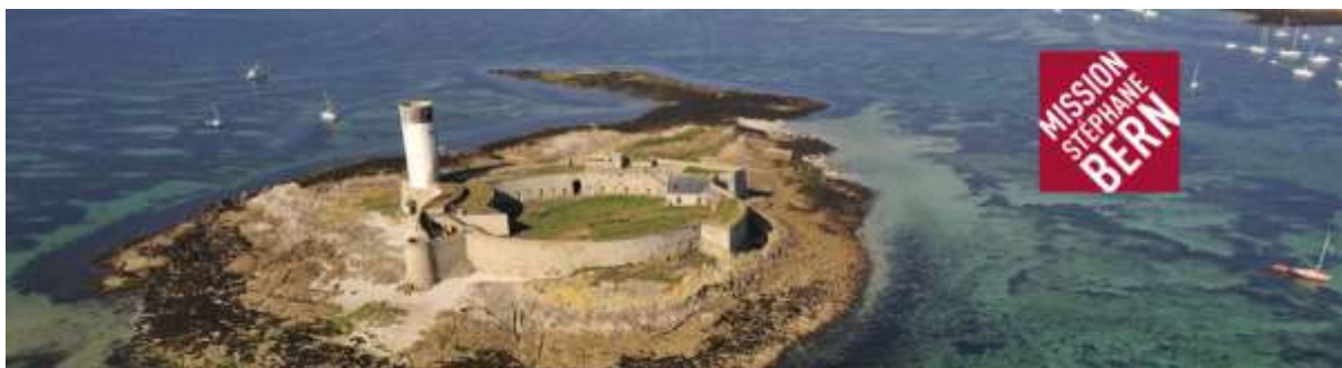
Le Fort Cigogne, dans l'archipel des Glénan, classé MH et restauré, pourra accueillir dans des conditions satisfaisantes les stagiaires du centre nautique.
