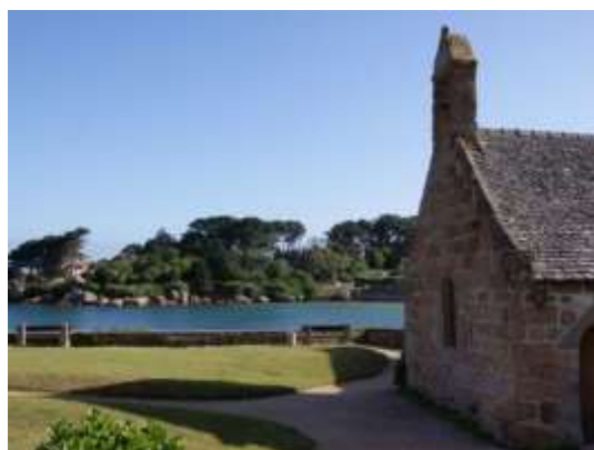
Le chantier de restauration de la chapelle Saint Guirec à perros-Guirec bénéficie du soutien de la Fondation Delestre et de la Fondation du Patrimoine.
