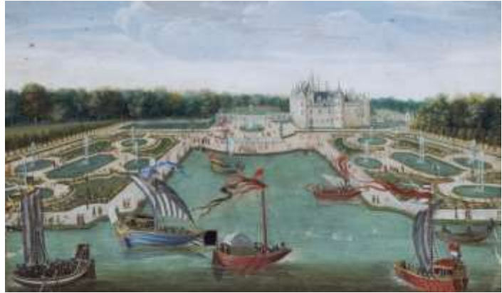
L'Institut de France est propriétaire du château de Chantilly abritant le musée Condé. Le château, les jardins et bassins du parc sont classés au titre des MH. Ils ont fait l'objet de très importantes restaurations.
