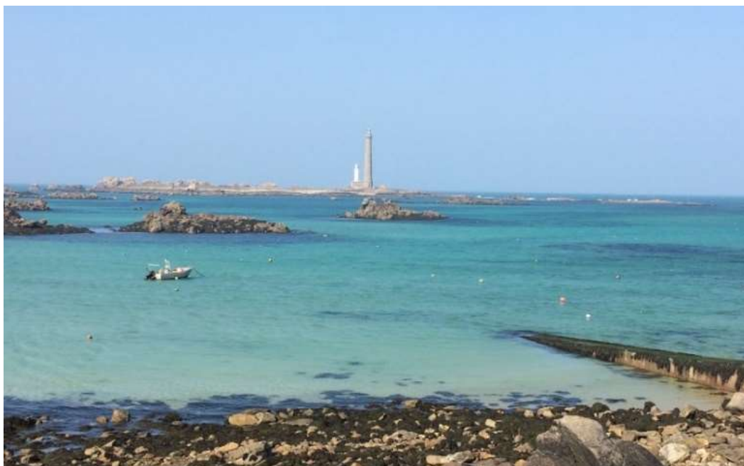
Le vieux phare de l'Île Vierge, dans l'aber Wrac'h, bâti en 1845, est aujourd'hui éteint. Il a été restauré entre 2018 et 2021 sous la maîtrise d'ouvrage de la Communauté de Communes du Pays des Abers. Il abrite désormais des gîtes touristiques. Le nouveau phare, allumé en 1902, est le plus haut d'Europe (82 mètres). L'intérieur du fût en pierre de Kersanton est entièrement revêtu d'opaline. Forte du succès de la première étape, la communauté de communes envisage de se lancer dans la restauration du grand phare.
