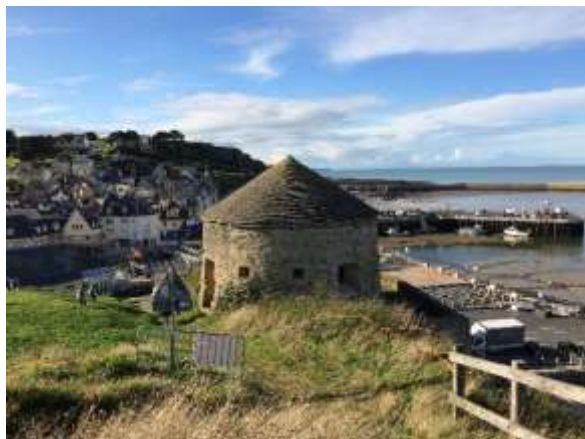
La Tour Vauban de Port-en-Bessin, classée MH, vue du Nord.
