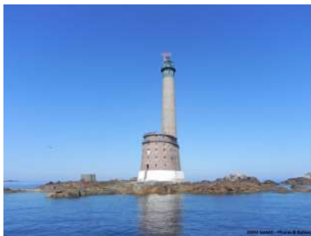
Le phare des Roches Douvres, au large de Bréhat est, en Europe, le phare le plus éloigné des côtes. La tour métallique originelle de 1870 ayant été détruite pendant la guerre, il a été reconstruit entre 1947 et 1954 en granit rose de Ploumanac'h et en granit gris de Trégastel. Les cinq étages de la base offrent des conditions de travail et de vie confortables aux gardiens. C'est sur le site des Roches Douvres que se déroule l'action des Travailleurs de la mer de Victor Hugo. Le phare des Roches Douvres sera-t-il le Cordouan du XX ème siècle ?
