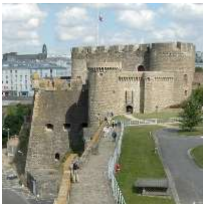
Le donjon du château de Brest, classé MH, a été restauré pour abriter les collections du Musée National de la Marine
