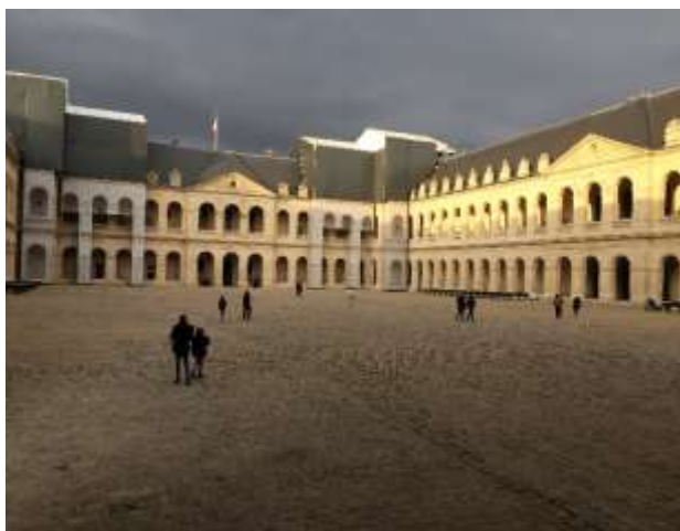
Les travaux de restauration et d'entretien de l'Hôtel des Invalides sont réalisés dans le cadre du protocole interministériel Culture-Défense qui permet un cofinancement des deux ministères. Les bâtiments classés MH abritent le Musée de l'Armée.
