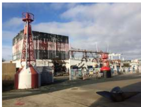
Le slipway de la Rochelle, est situé dans l'emprise du musée. Il est classé MH. Sa restauration permettrait de le remettre en fonctionnement et de l'utiliser pour l'entretien des bateaux patrimoniaux.
