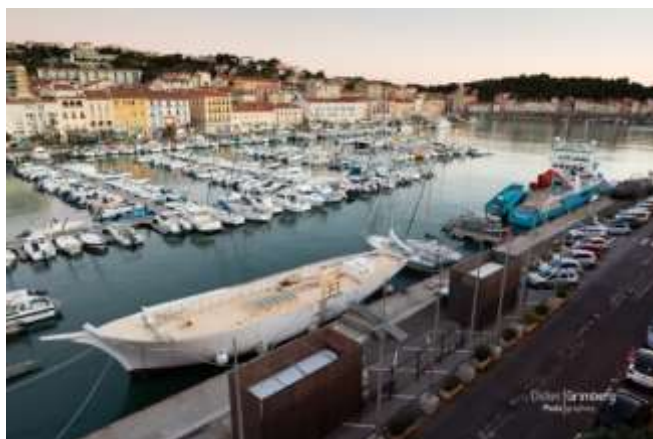
La goélette Miguel Caldentey dans le port de Port-Vendres. On distingue les containers qui abritent le chantier de restauration.
