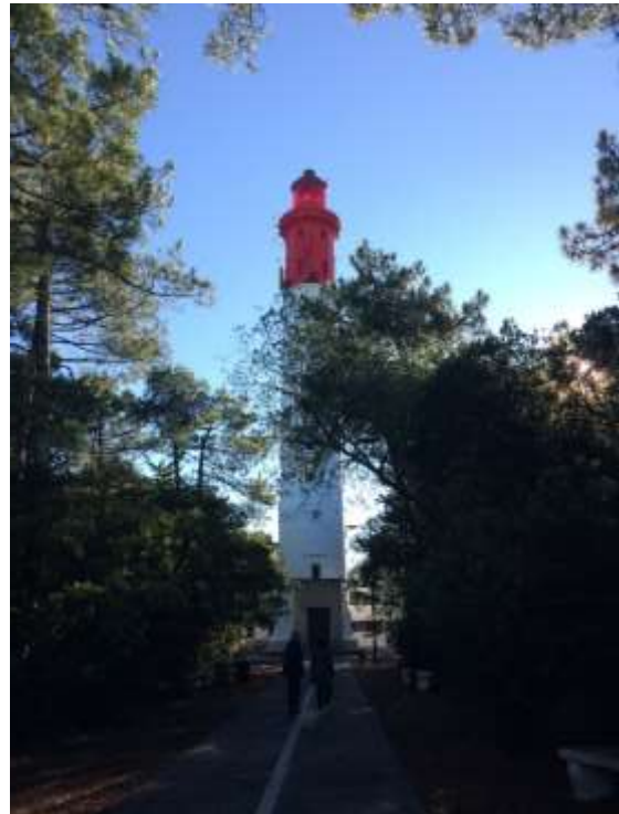
Le phare du Cap Ferret a été reconstruit en béton après la guerre. Il est inscrit au titre des MH. Il a été l'objet d'une restauration complète portée par la DIRM et l'Office du Tourisme. Une extension contemporaine a permis d'y loger un musée. Le nombre de visiteurs est passé de 15 000 à 130 000 grâce à cet investissement. Trois postes financés par la ville ont été créés pour assurer la gestion du site.
