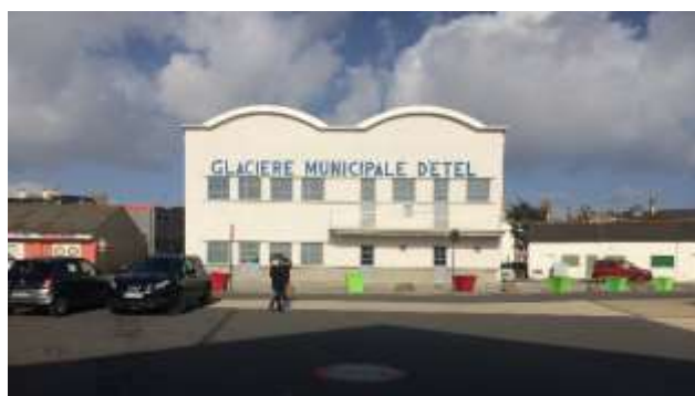
La glacière d'Etel a été restaurée par la commune, avec l'aide de l'ABF et de la fondation du Patrimoine. Elle pourrait accueillir le musée des thoniers...
