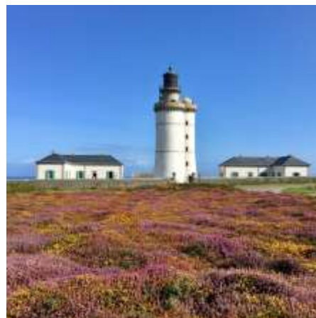
Le phare du Stiff à Ouessant, construit par Vauban en 1699 est classé MH. Il appartient à l'Etat. Il a été entièrement restauré entre 2013 et 2014 sous la maîtrise d'ouvrage du Conservatoire grâce à un partenariat avec la DAM et la DRAC Bretagne. Il remplit toujours sa mission de signalisation maritime. Il est ouvert au public grâce à des guides recrutés par la commune d'Ouessant.
