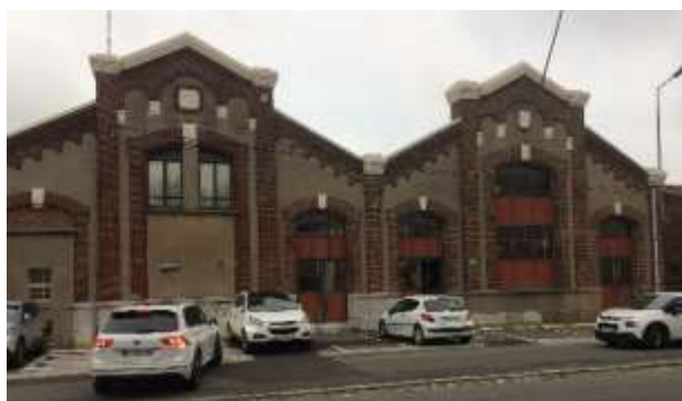
Bâtiments des pompes de formes de radoub de Calais : un patrimoine industriel et portuaire de qualité non protégé à ce jour.
