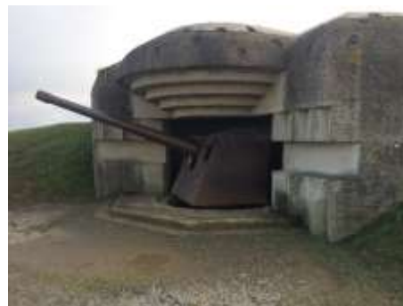
L'une des casemates de la batterie de Longues-sur-Mer (14), classée MH
