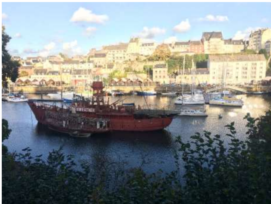
Le Scarweather, magnifique bateau-feu du Port-Musée de Douarnenez, nécessite une importante restauration. Certains travaux ne peuvent être effectués sur place, ce qui rend l'opération plus coûteuse encore.
