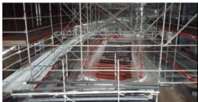
Le chantier actuel sera l'occasion de rouvrir au public l'escalier historique du palais de Chaillot.
