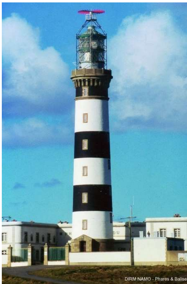
Le phare du Créac'h et ses dépendances abritent le Musée des Phares-et-Balises d'Ouessant. Le projet de restauration bénéficiera du FIM dès 2022
