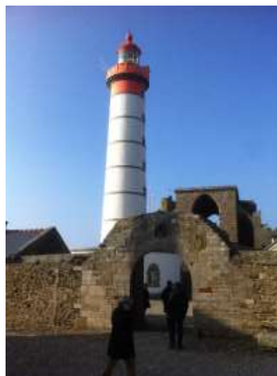
L'ancienne abbaye Saint-Mathieu de Fine-Terre est classée MH depuis 1875 en raison de la qualité de son architecture médiévale. Son clocher servait de phare pour signaler l'entrée de la rade de Brest. C'est en 2005 seulement que le phare a été protégé au titre des MH comme élément du patrimoine maritime.
