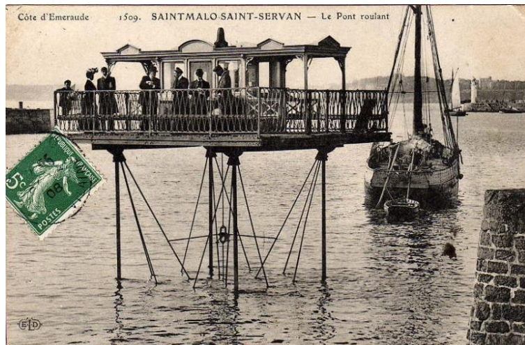
Le pont roulant à marée haute. On voit distinctement la structure en fers entrecroisés et la cabine centrale avec sa partie fermée, ses parties couvertes et les bancs extérieurs. Source Internet.
