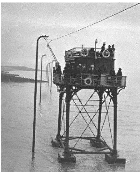
Le premier Pioneer, avec la ligne d'alimentation électrique et les deux perches de captation de type trolley. Source Internet.
